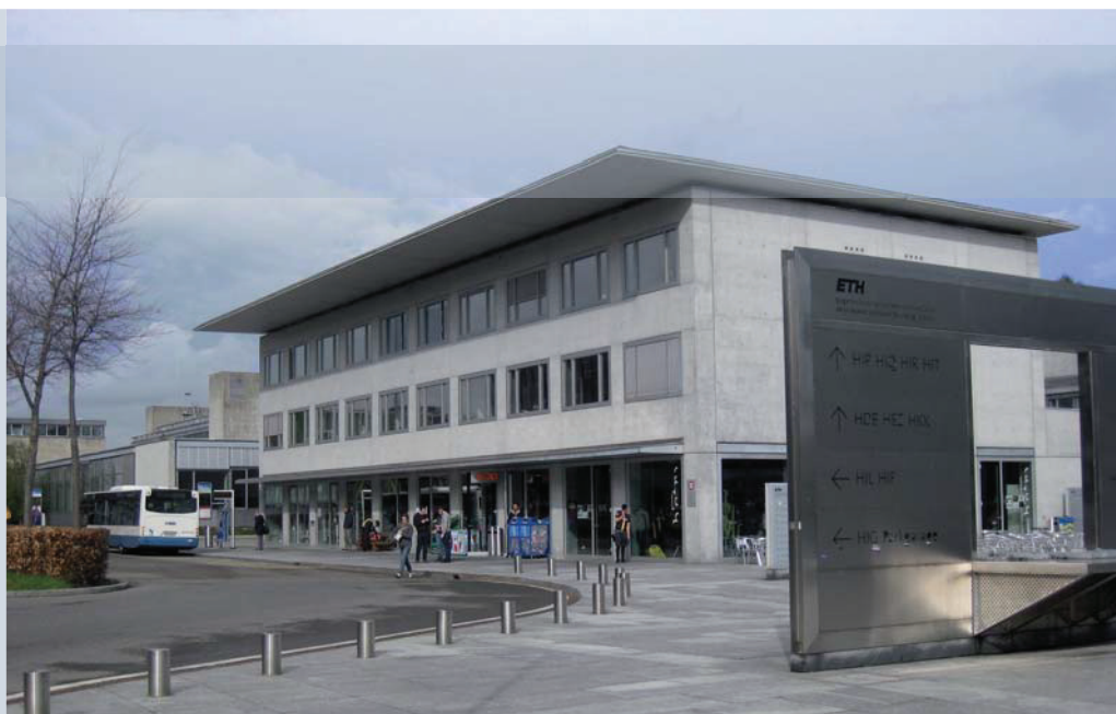
Gebäude HPI am ETH Standort Hönggerberg in Zürich.
